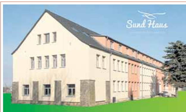
SundHaus während der Bauphase.
