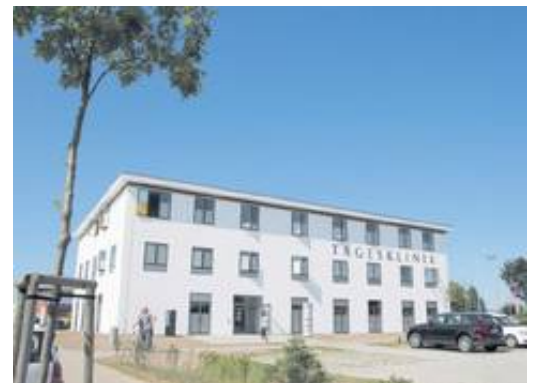
Nach 14 Monaten Bauzeit wurde am Freitag die Uhlenhaus Tagesklinik feierlich eröffnet. (Foto: Daniela Witt-Wermke)
