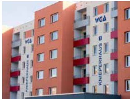
Neu gestaltete Fassade am KNIEPERHAUS 1
